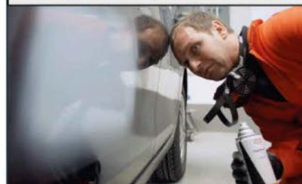
Pulverice la superficie al finalizar el proceso de lijado y compruebe si quedan rayas en el aparejo o aguas en la masilla.
